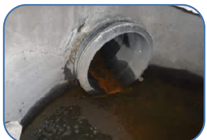
effluent 21-inch pipe
