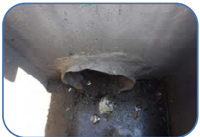
effluent pipe
