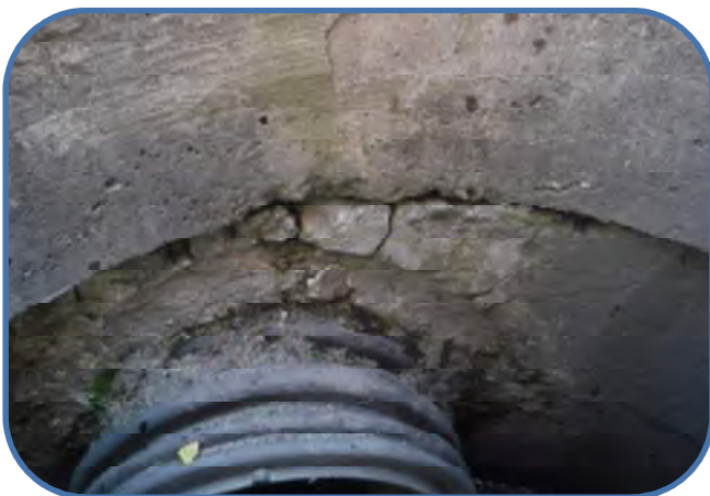
effluent cracked grout
