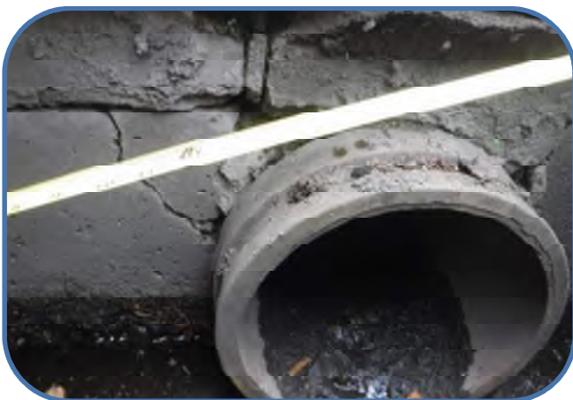
cracks on base effluent pipe
