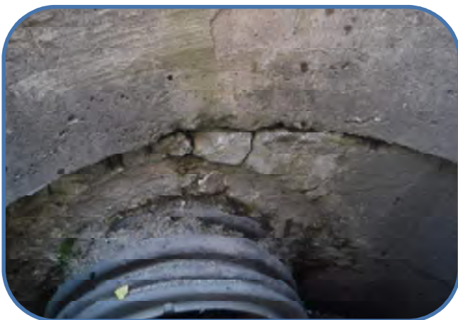
effluent cracked grout
