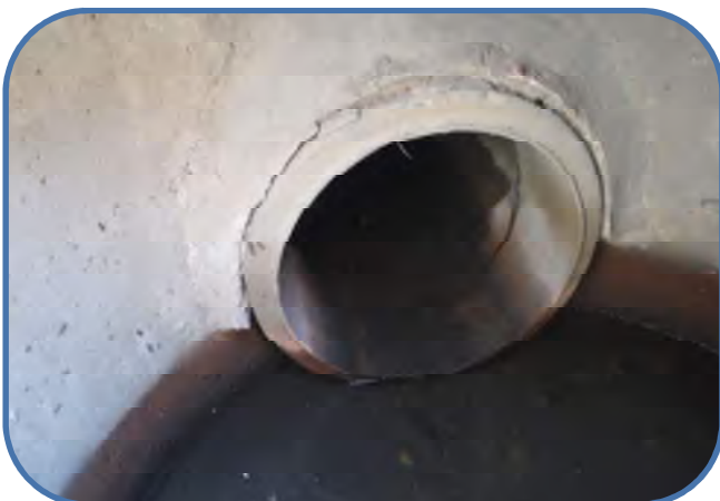
effluent pipe
